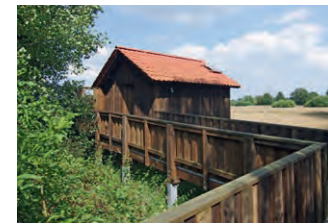
Barrierefreie Beobachtungshütte am Südrand des Venns.
